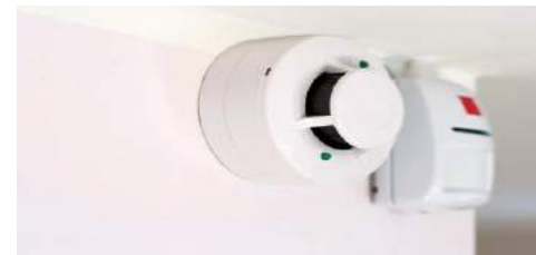
Sistema detector de humos (prevención de incendios)
